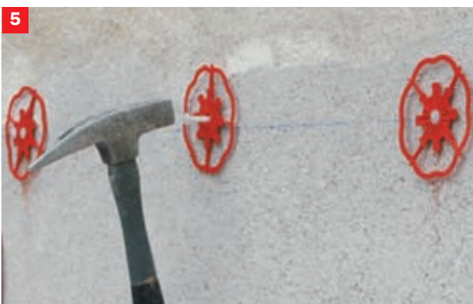
5. Baumit StarTrack se vsadí do vyvrtaného otvoru a upevní se zatlučením plastového trnu.
