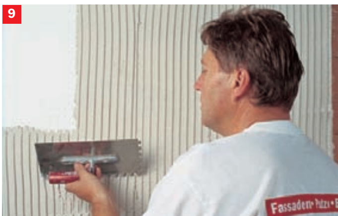
9. Na přebroušené fasádní desky se ozubeným nerezovým hladítkem nanese Baumit openContact.
