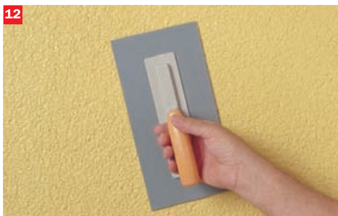
12. Po výše uvedené technologické přestávce (min. 24 h) se nanese konečná povrchová úprava z omítek Baumit openTop nebo Baumit NanoporTop.
