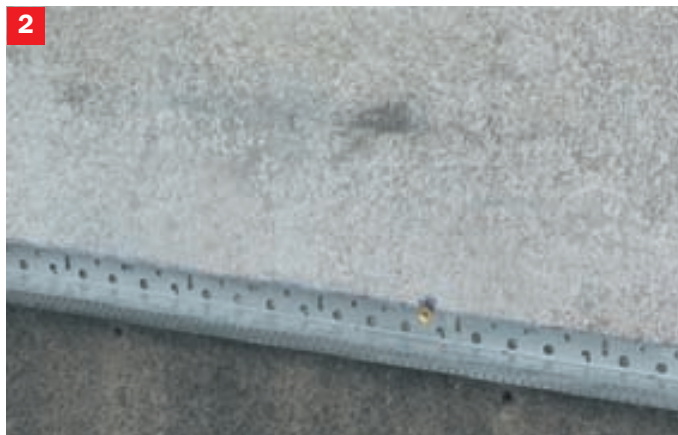
2. Před montáží Baumit StarTrack je třeba osadit soklový profil standardním způsobem jako u jiných tepelně izolačních systémů.
