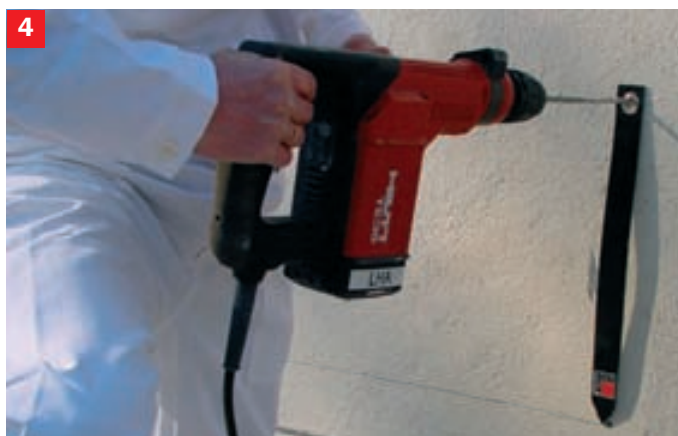
4. Hloubka vyvrtaného otvoru pro Baumit StarTrack red a orange musí být nejméně 9 cm, pro Baumit StarTrack blue alespoň 6 cm, a pro Baumit StarTrack green a Duplex pak 14 cm. Příklep se smí použít pouze při vrtání do betonu či plných cihel. Svislou vzdálenost max. 40 cm je možné vyměřovat např. pomůckou podle obrázku.
