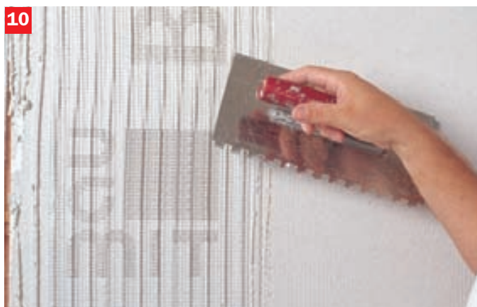
10. Do vrstvy lepicí stěrky Baumit openContact se vloží sklotextilní síťovina Baumit openTex.
