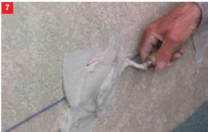
7. Bezprostředně před osazováním tepelně izolačních desek se na talíře Baumit StarTrack nanese cca 1–2 cm tlusté bochánky lepidla.
